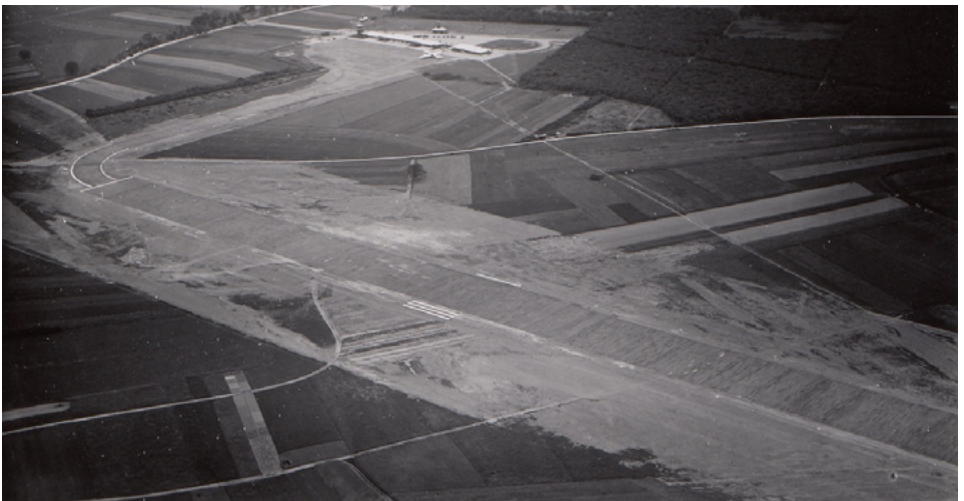
29.5.1946 Empfangshalle, Rollbahn und Piste
