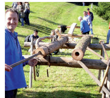
17 Düchel bohre Stamm durchbohren
